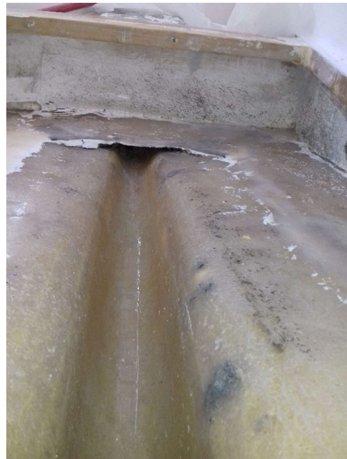
Vue vers l'avant (cloison proche du tube d'étambot)
