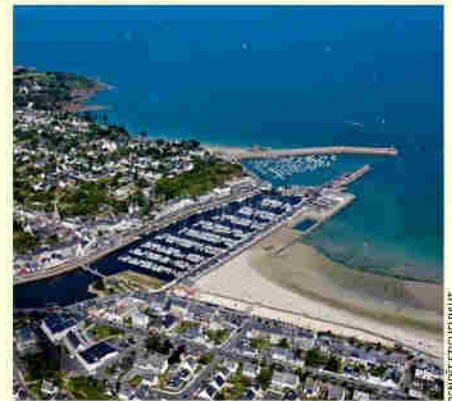
A Binic, le temps d'ouverture du bassin à flot doublera presque, grâce à l'installation d'une nouvelle porte hydraulique.
