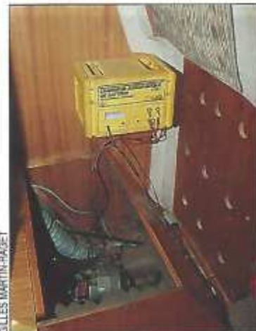
La gestion de la consommation électrique est délicate et le voilier comporte, outre un chargeur, quatre batteries de servitude.
